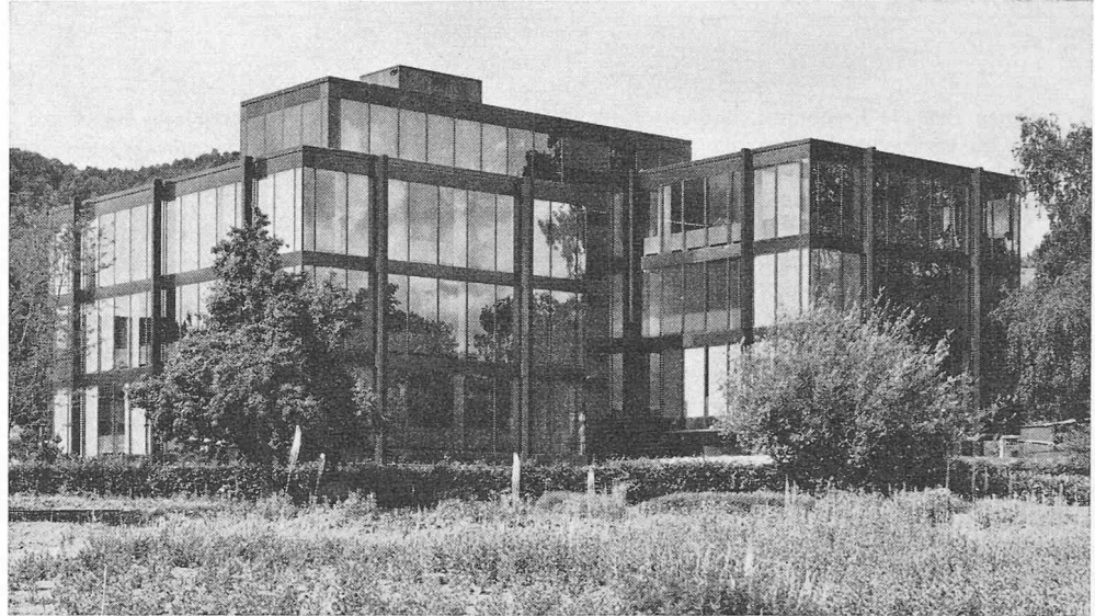
Bild 1. Glasfassade des Verwaltungsgebäudes der Ventilator AG, Stäfa mit Stop-Ray-Festverglasung
