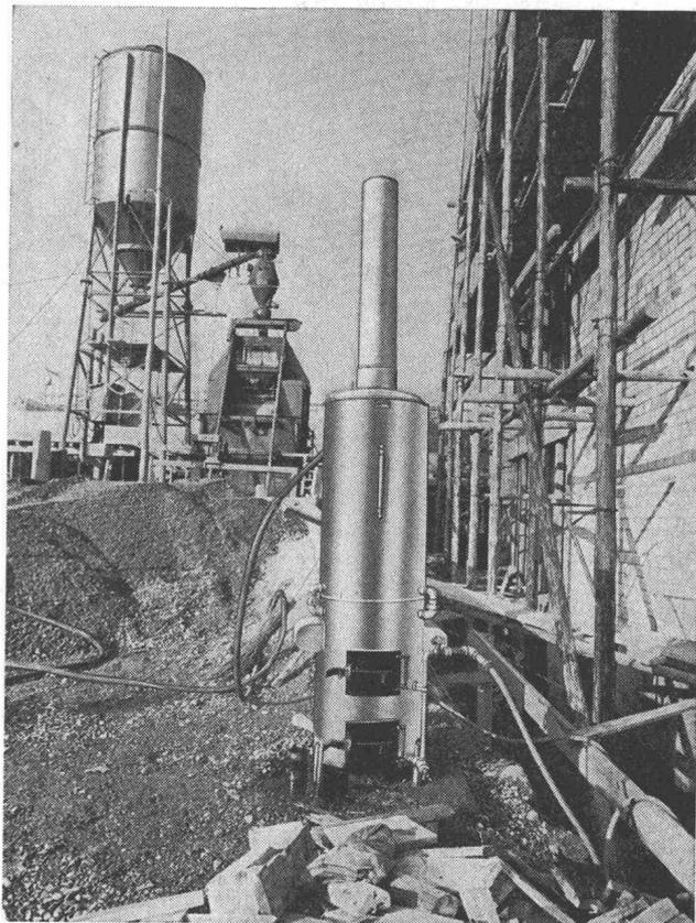
**Heisswasser- und Dampfkessel** für Holz-, Kohlen- oder Oelfeuerung mit 3,5 m<sup>2</sup> Heizfläche. Gefahrlose Konstruktion, konzessionsfrei. Leergewicht ca. 160 kg. Leistung pro Stunde 1000 Liter Wasser zu 60 Grad oder 90 kg Dampf = 60 000 WE. Brennstoffverbrauch pro Stunde 18 kg Holz oder 12 kg Kohle.
