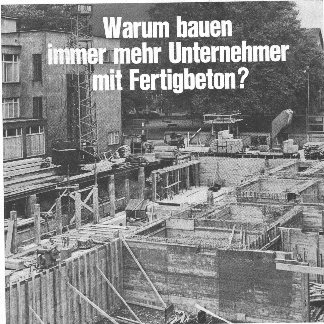
Erweiterungsbau Gewerbeschule der Stadt Zürich. Bauunternehmung: Bau AG für Hoch- und Tiefbau, Zürich
