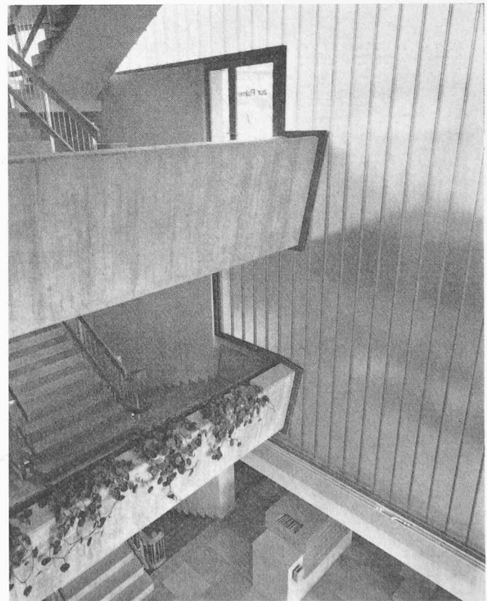
Bild 5. Treppenhalle mit Beton-Podestbrüstungen und Glaswand
