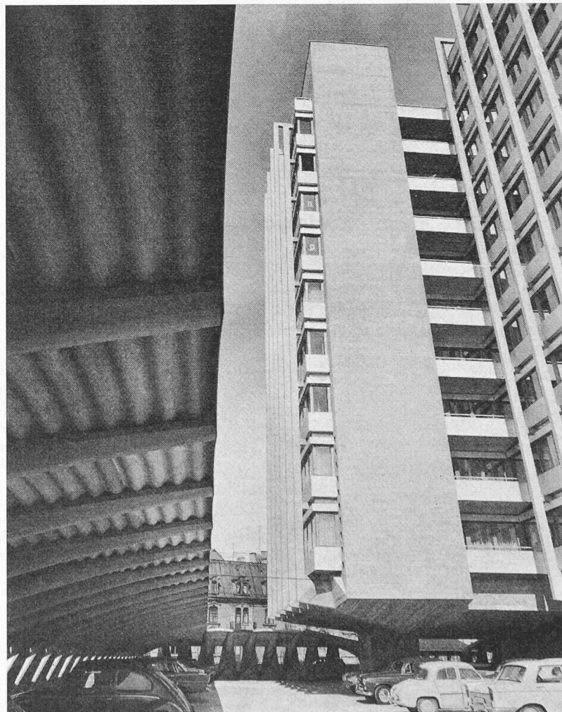
Bild 2. Parkingterrasse (zweites Obergeschoss). Die Tragelemente der Schutzdächer wurden vorfabriziert und mit Vorspanndrähten an der Aussenbrüstung befestigt
