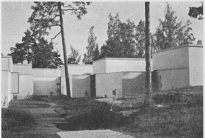
Bild 4. Rückseite von Terrassenhäusern an der Meeresküste. Die Aussen- seite der hufeisenförmigen Anlage ist zweigeschossig. Alle Wohn- und Schlafräume befinden sich in dem sehr aufgelockerten oberen Geschoss
