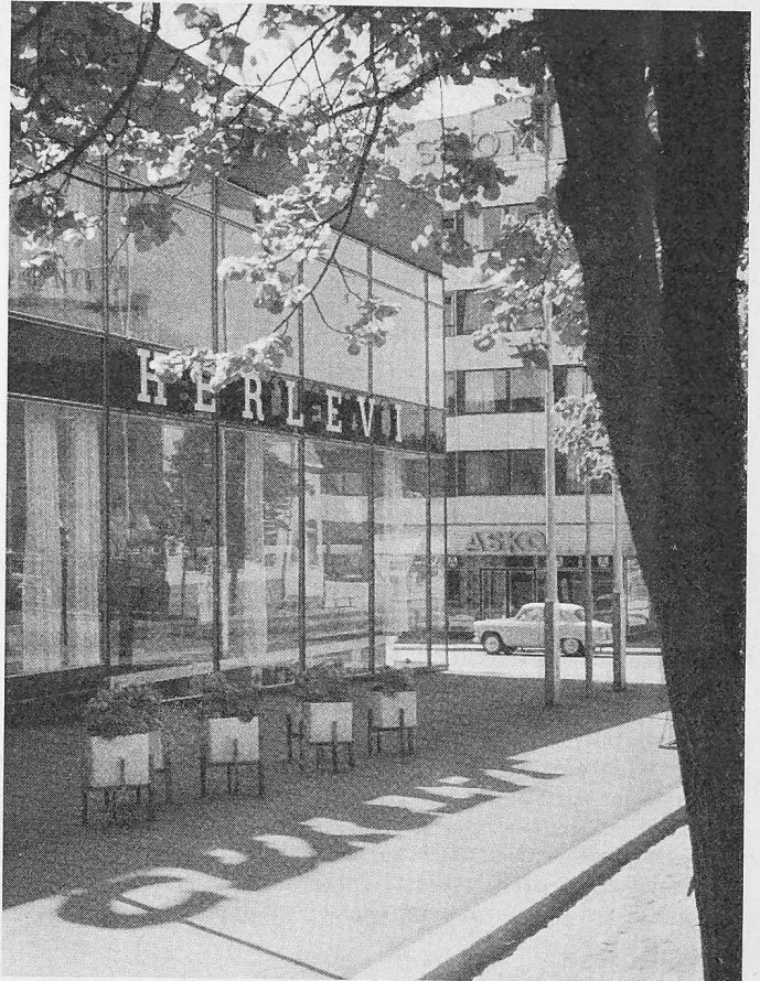
Bild 12. Geschäftshaus und Restaurant in Porvo. Trotz der Härte des Klimas entstehen in Finnland solche zarte Blüten einer fast unwirklich leichten Architektur aus Glas, Leichtmetall und gerilltem Kupferblech
