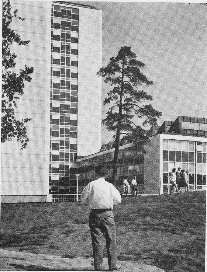
Bild 10. Spital in Helsinki. Durch die feine Wellenstruktur der vollen Fassadenteile und die flächig-graphische Behandlung der verglasten Partien wirkt das Gebäude trotz der enormen Dimensionen und der industriemässigen Bauelemente ausgesprochen zierlich
