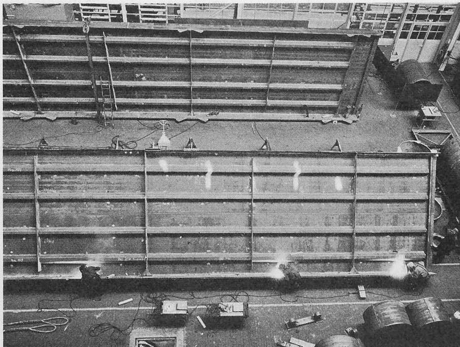
Bild 12. Schweissarbeiten in der Werkstatt. Im Hintergrund ein fertiges Element mit den Knotenblechen für den Anschluss der Windverbandstäbe
