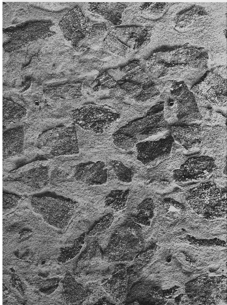
Bild 2. Injektionsbeton mit Murger-Sernifit
