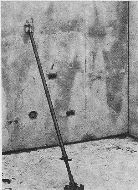
Bild 2. Zwischenwandplatten mit tapezierbereiter Oberfläche und Installationseinlagen. Abstützen und justieren mit Hilfe von Teleskopstreben (System Peikert)
