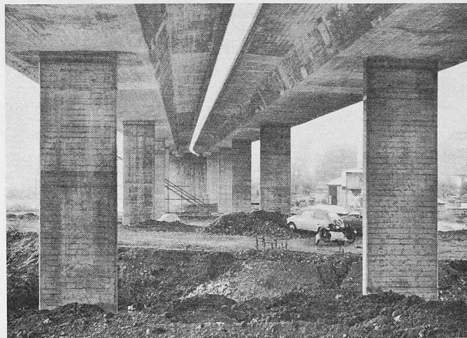
Bild 3. Viadukt Bisio im Zuge der Nationalstrasse N 2 Lugano—Chiasso. Gesamtlänge 455 m mit konstanten Feldweiten, welche ein fortschreitendes Umsetzen des Lehrgerüsts gestatten
