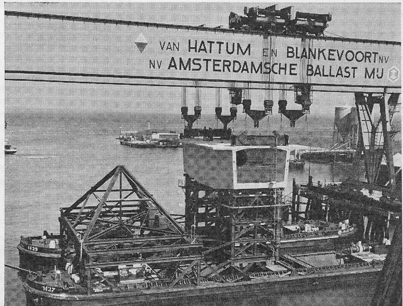
Bild 29. Der Transport von Pfeileraufsätzen und Hammerstücken geschieht mittels eines speziell ausgerüsteten Schiffes
