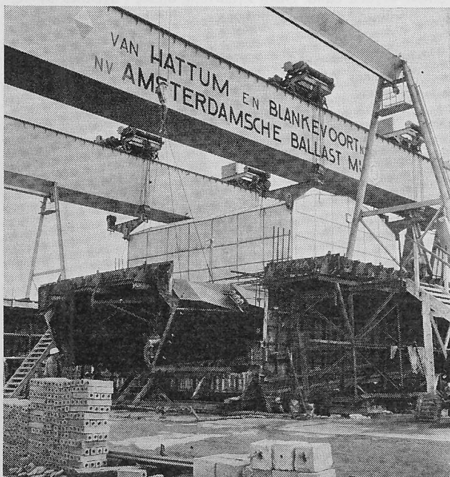
Bild 25. Die Innenschalung für die B-Einheit wird eingefahren
