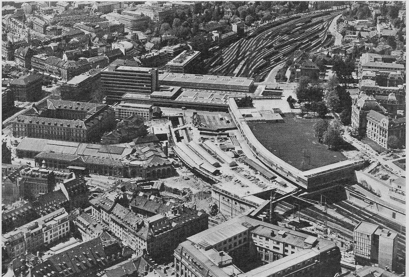
Bild 14. Bahnhof Bern, Flugaufnahme aus Nordosten. Bauzustand am 3. Mai 1966
