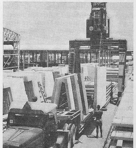
Bild 2. Lagerung und Abtransport der Fertigbauteile
