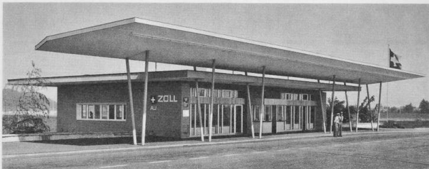
Ansicht: Strassenseite mit Ueberdachung für die Abfertigung des Personenverkehrs
