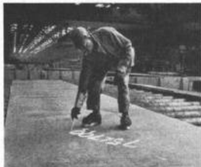
Bezeichnung heisser Stahlplatten mit MARKAL Type H-Stiften.
