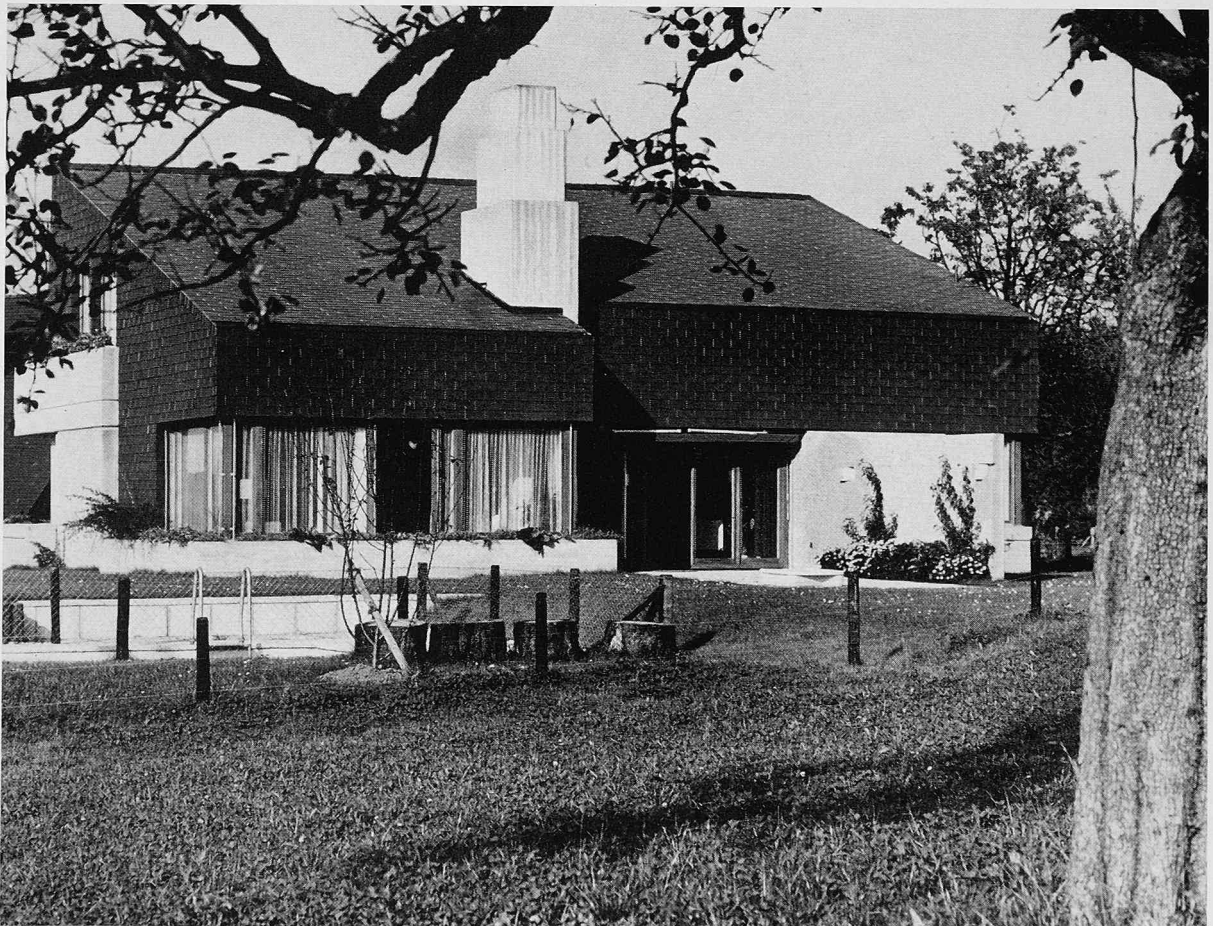
Südansicht mit Fensterfront gegen den Garten, Vorn links das Schwimmbecken
