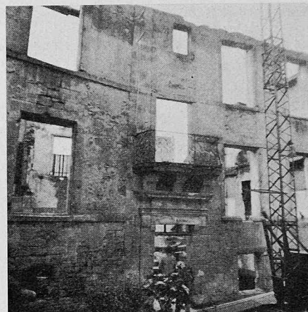
Die Fassaden bleiben, das Innere wird neu
