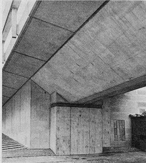
Bild 11 (links). Detail beim Widerlager Hirschengraben
