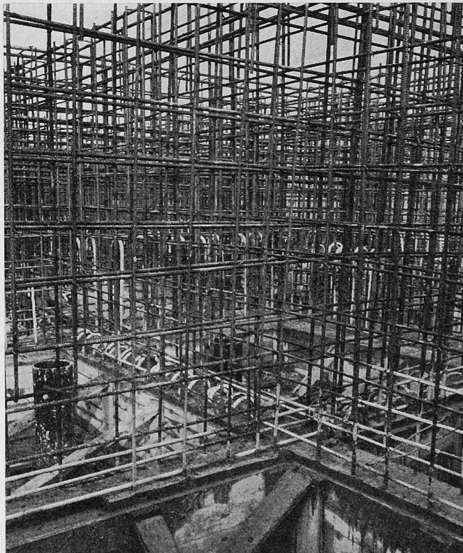
Bild 3. Gute Anordnung der Armierung in Silozellen. Gegenüber der Lösung in Bild 2 konnte die gleiche Arbeit (Armieren, Schalen, Betonieren) in der halben Zeit bewältigt werden
