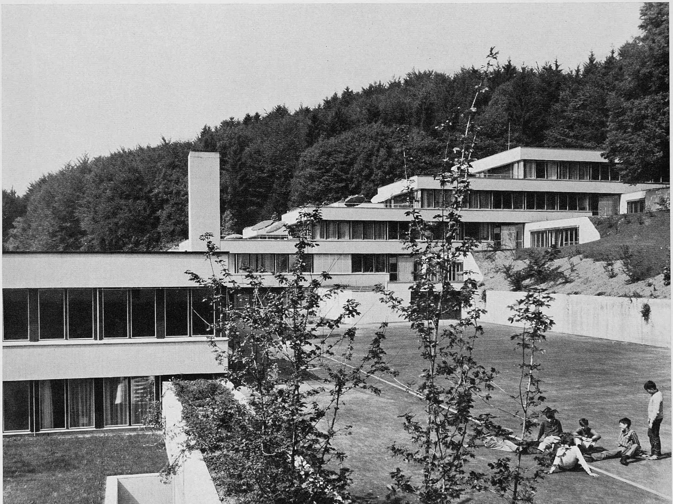
Ansicht von Südosten. Links Schulbau. Hinten rechts der östliche Beobachtungstrakt (Wohnpavillons und Beobachtungsstationen). Im Vordergrund Pausenplatz in Verbindung mit Eingangshof
