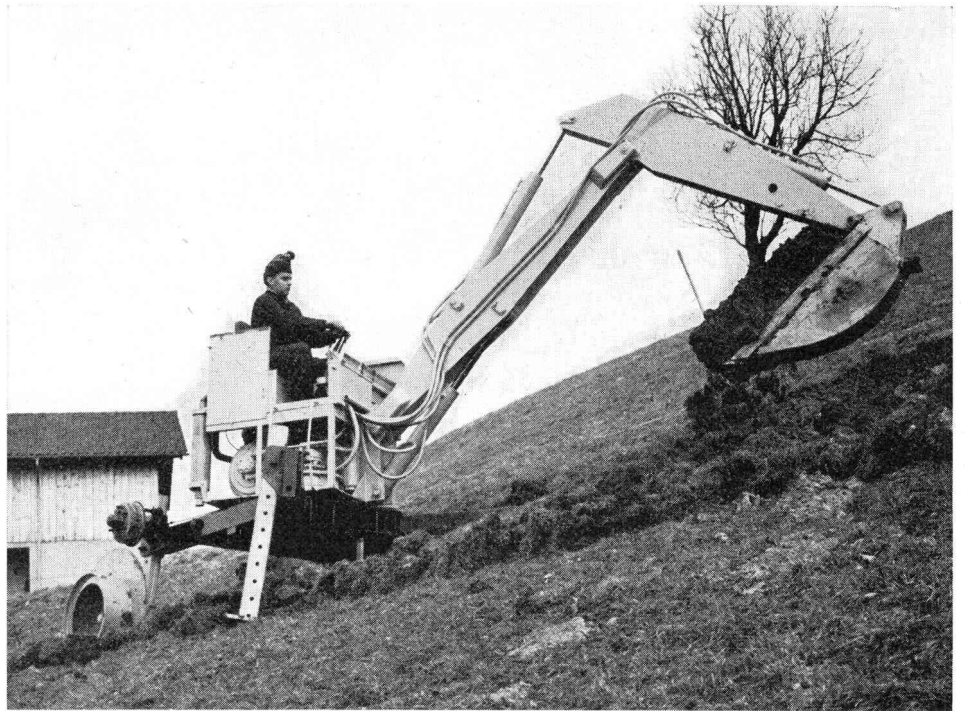
So arbeitet der MUK 3000 am Hang.
