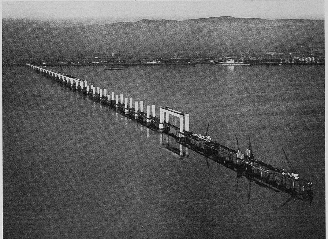
Bild 9. Die Brücke über den Firth of Tay im Bau; Blick gegen Dundee
