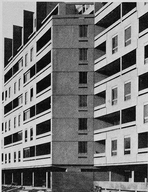
Immeubles Type A, détail de façade
