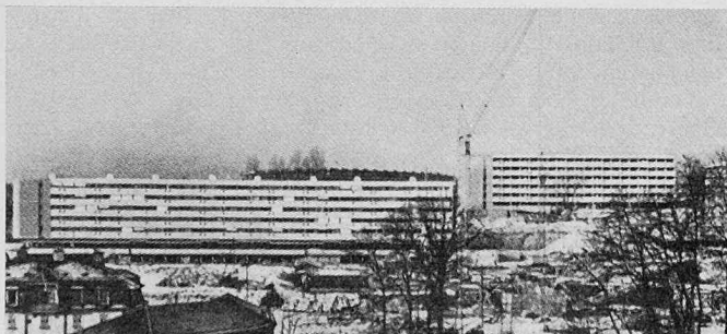
Vue générale prise de l'est
