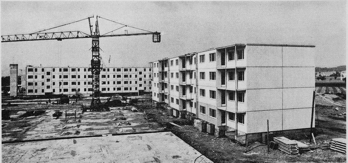
Ueberbauung in Volketswil, Ansicht von Osten gegen die Ifangstrasse
