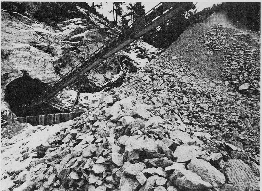
Bild 4. Ausbruchmaterial in natürlicher Schüttung, Stückgrösse im Vordergrund 20–30 cm
