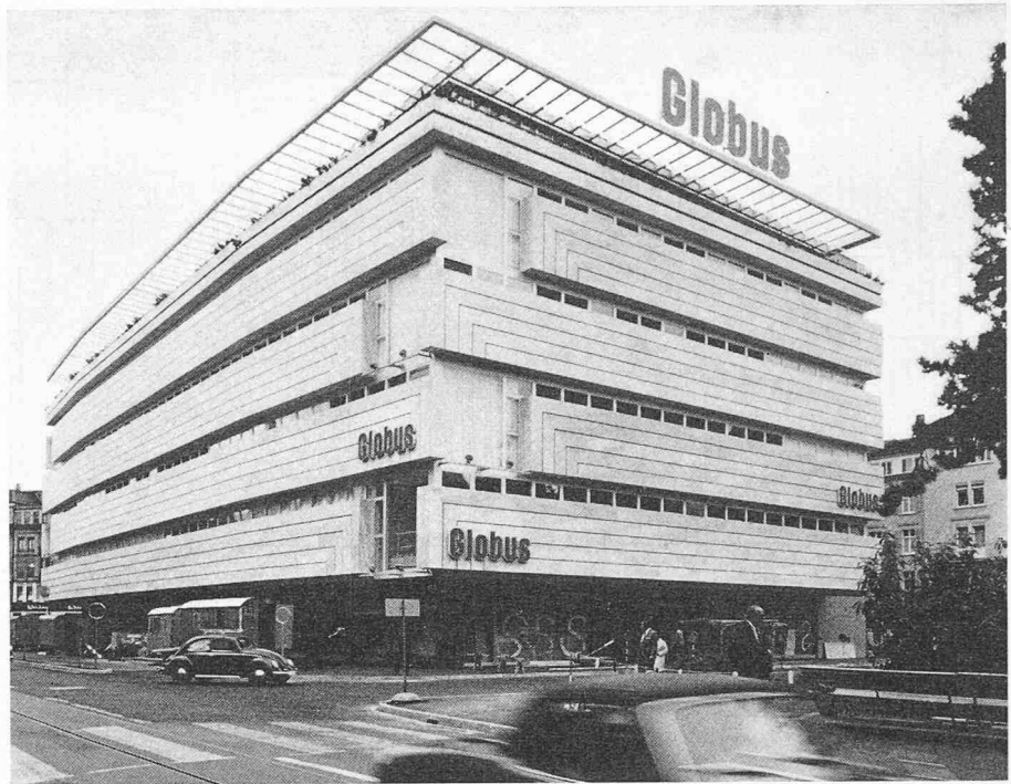
Der neue Zürcher Globus, von der Usterstrasse her gesehen. Die wichtige Fassadenkomposition verleiht dem Warenhaus den gewünschten attraktiven Charakter. Die vorgeblendeten Marmorbänder bringen die bauliche Struktur in einer eher graphisch empfundenen Betonung der Stockwerke zum Ausdruck ohne Bezug auf die tragende Konstruktion Phot. Georges Wino, Zürich
