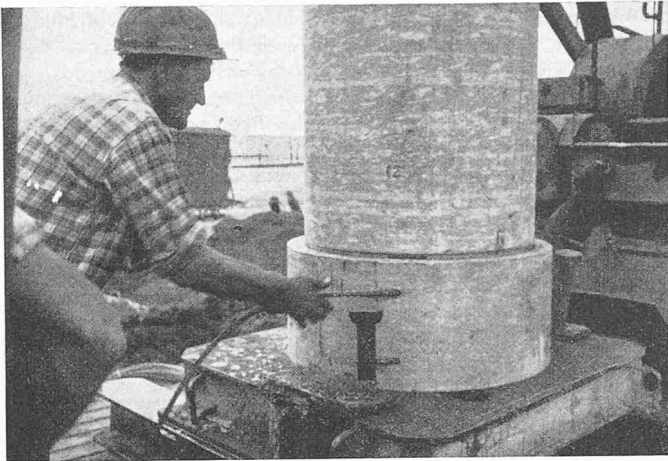
Bild 3. Einführung des als Scherkörper wirkenden Chromstahlseiles in die Ringnut der zugfesten Steckmuffe bei Vertikal-Brunnenrohren
