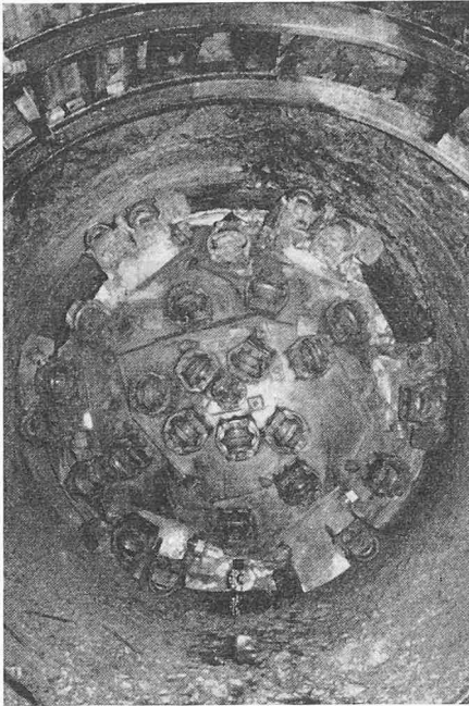
Bild 4. Gesamtansicht Bohrkopf. Die Vorderfront bildet eine kreisrunde Panzerplatte, die mit 28 Rollenmeisseln (Diskusmeisseln) sowie einem Zentralbohrer bestückt ist
