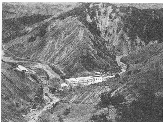
Bild 6. Das Kraftwerk Fontes, gesehen von Westen mit Erosionsrinnen im Umgebungsland nach dem Hochwasser
