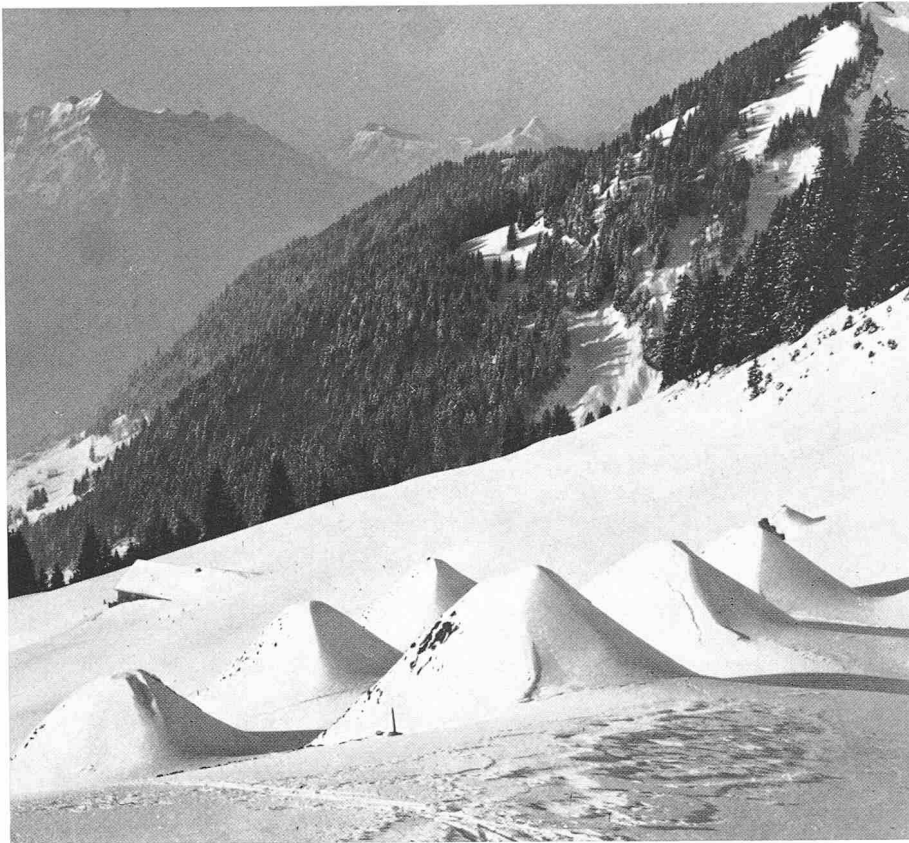
Lawinen-Bremshöcker aus Erdmaterial. Photo H. Frutiger, Eidg. Institut für Schnee- und Lawinenforschung Weissfluhjoch
