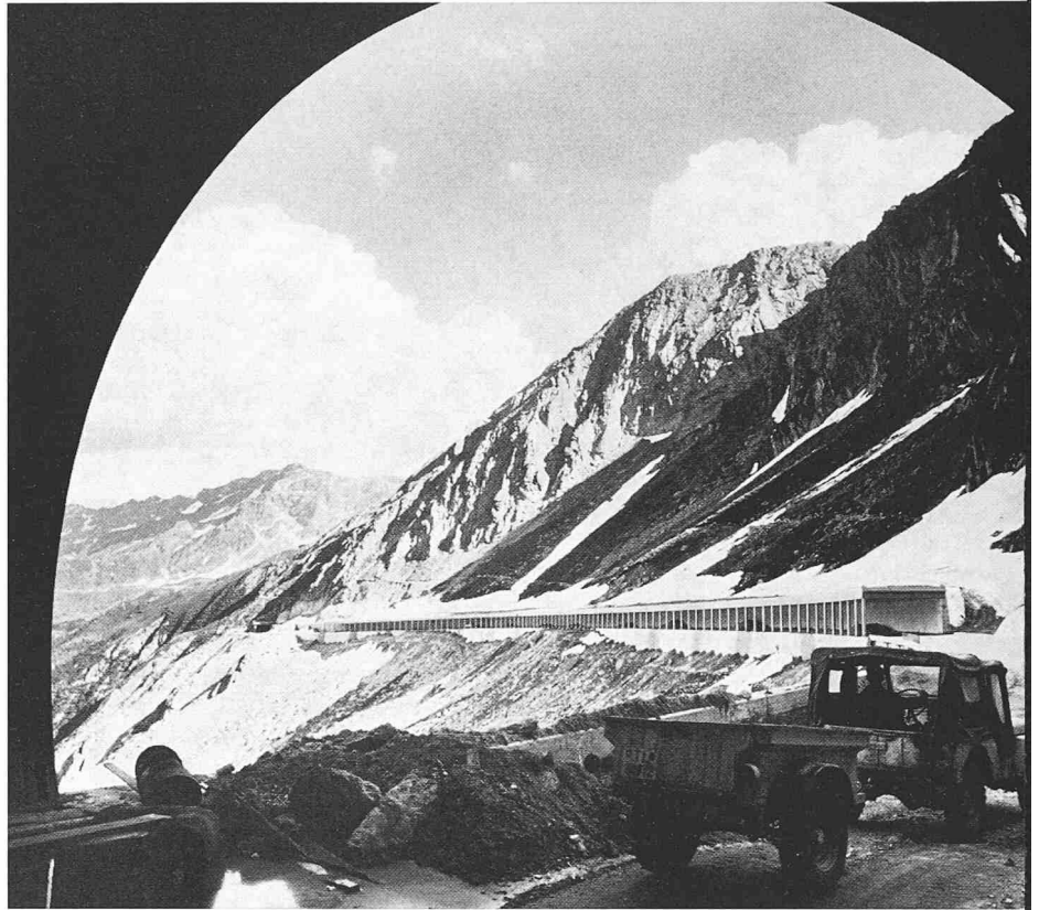
Nationalstrasse N2, Neubau des Abschnittes Motto Bartola—Gotthardpasshöhe, Galerie «Ganne di San Antonio». Photo Comet, Zürich
