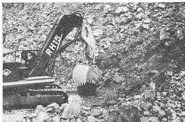
Bild 10. Aufnahmen und Beiseiteschieben grosser Steine aus dem Grabbereich. Das Bild zeigt eine typische Schaufelstellung, wie sie nur bei Hydraulik-Baggern möglich ist
