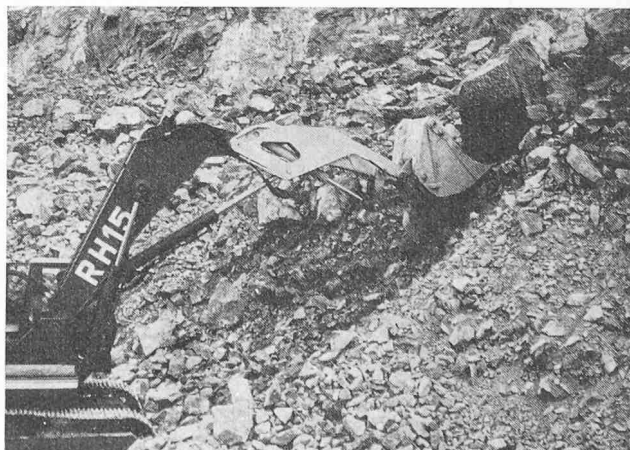
Bild 1. Das Herauslösen eines Knäppers aus der Böschung
