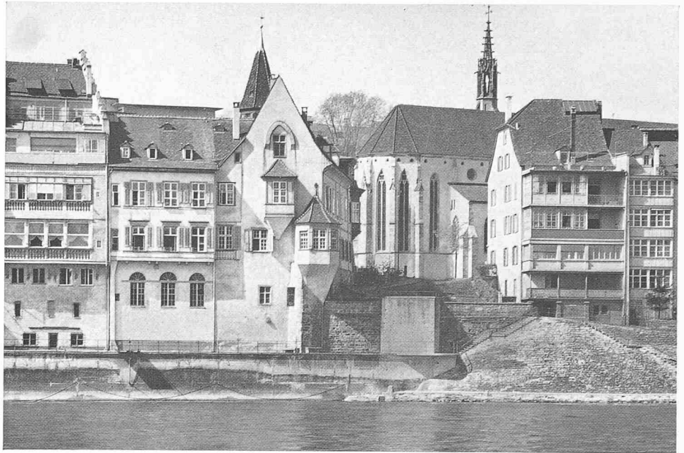
Chorpartie der Predigerkirche mit teils verdeckter Nordostflanke (1233—1269 und 1423). Die Konventsgebäude befanden sich auf der Südwestseite der Klosterkirche. Am Rheinufer Altbaslerhäuser St. Johann-Vorstadt. Abbildung 272, Seite 211
