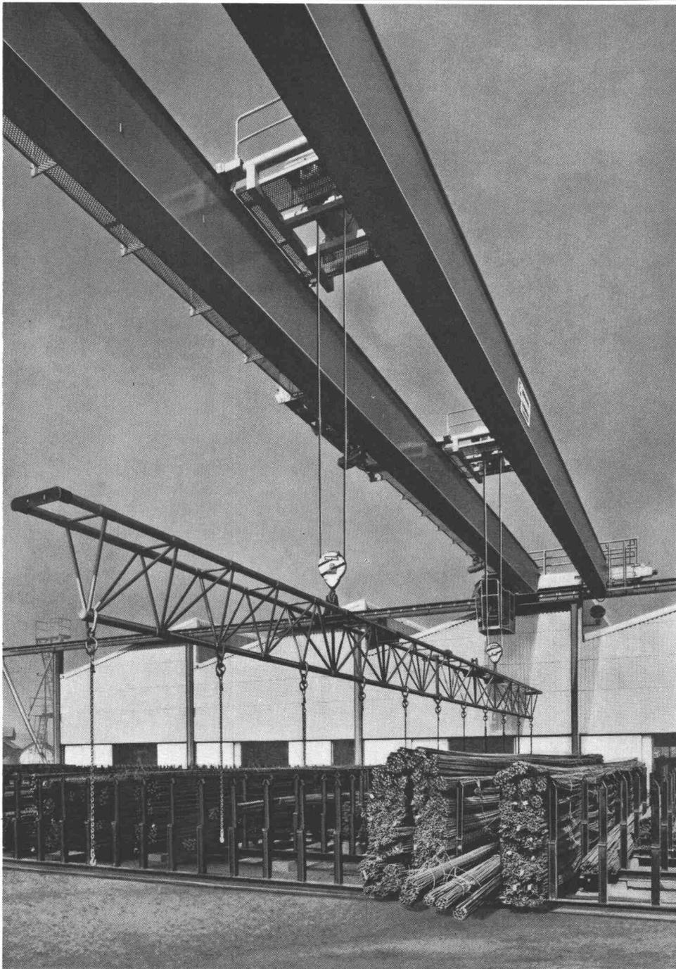
2-Träger-Laufkran, Tragkraft 10 t, Spannweite 33,5 m
