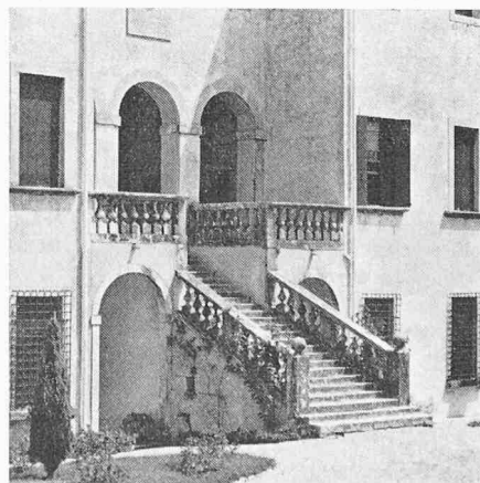
Villa Godi. Treppenaufgang zum Hauptgeschoss
