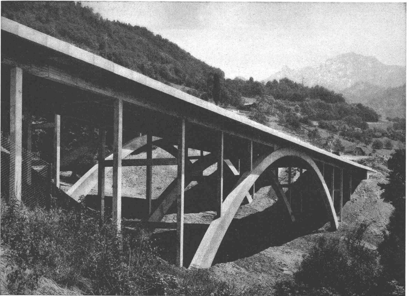
Autobahn N 9 Pont des Vuarennens, Chernex VD
