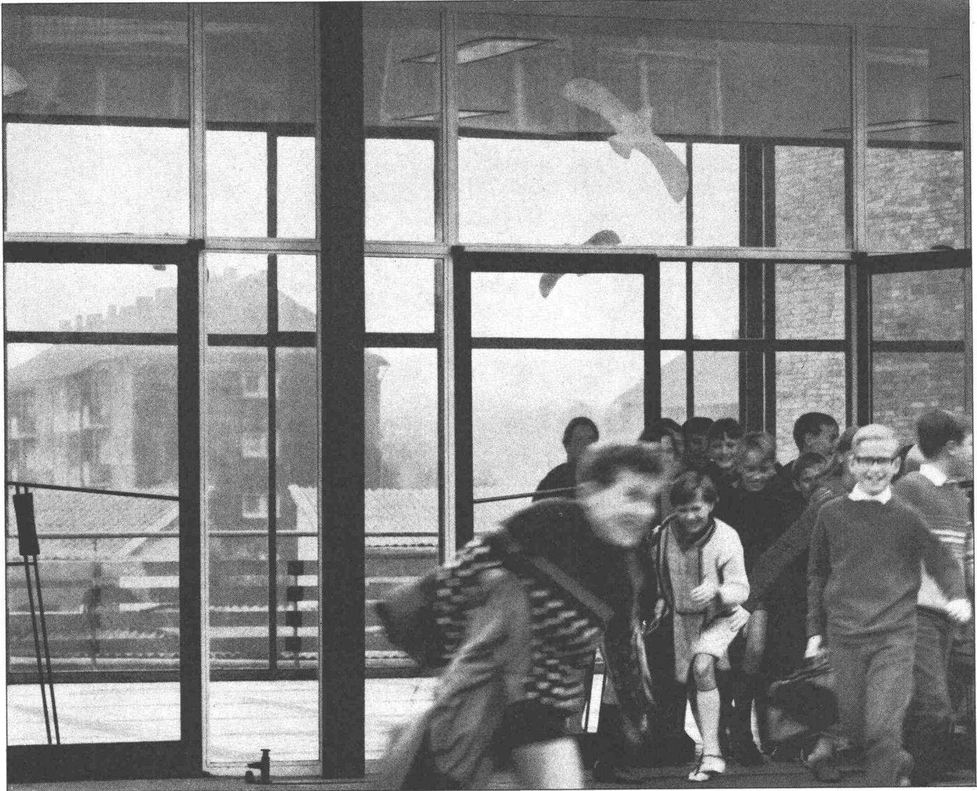
Solche Türen sollten splitterfrei sein!
