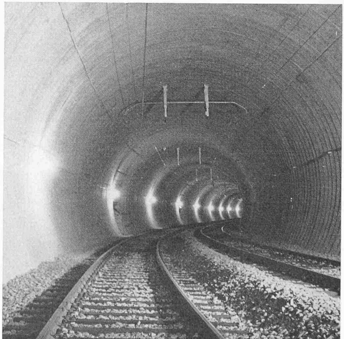
Bild 16. Donnerbühlentunnel mit unverkleideten Betontübbingen
