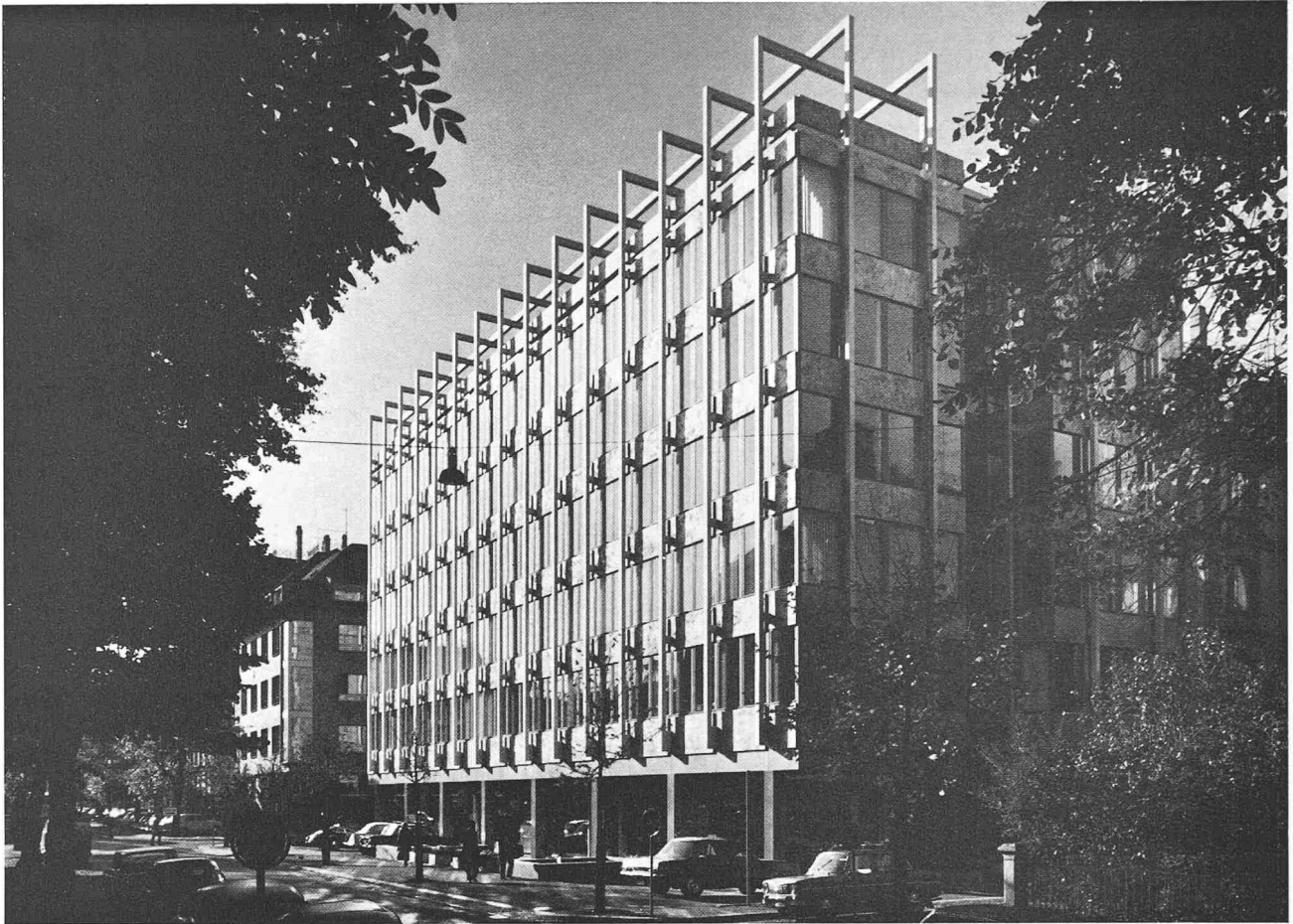
Hauptfassade an der Genferstrasse
