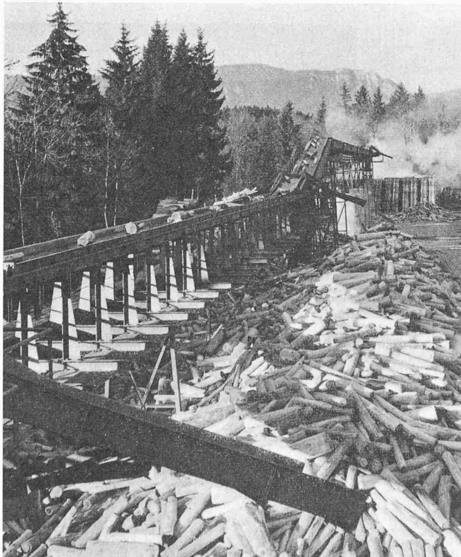
Bild 2. Teilansicht einer 170 m langen Förderanlage für Papierholz in einer Papierfabrik
