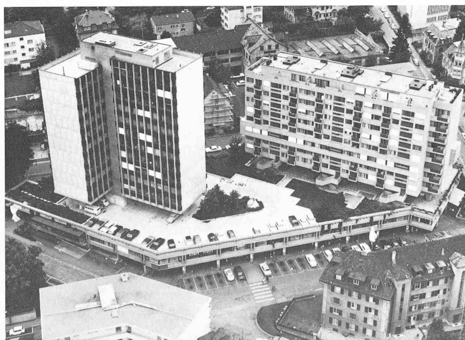
«Bauhof» in Zürich-Oerlikon Gubelstrasse 28—36 Bauherr: Dr. med. Hch. und Frau I. Reimann-Bächtold, Zollikon Architekt: BSA/SIA Werner Gantenbein Mitarbeiter: H. Bruderer
