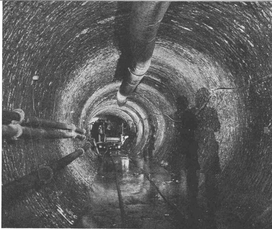
Druckwasserstollen Julia/Schweiz: Kurvenstrecke R=300 m Durchmesser 3,40 m
