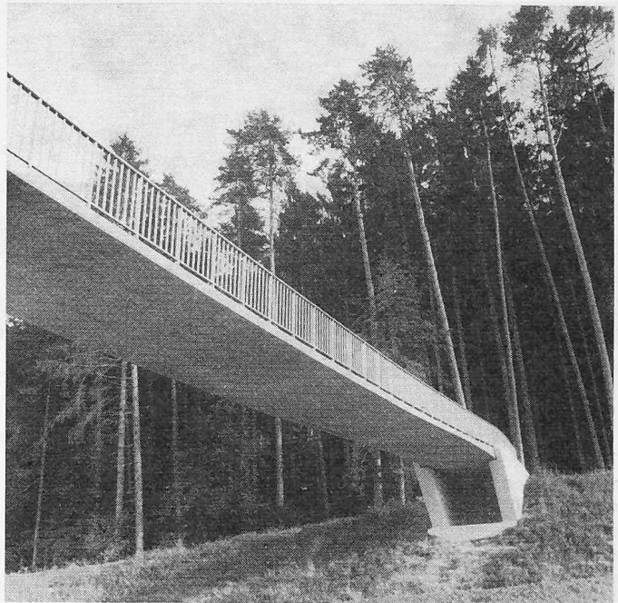
Bild 6. Untersicht und bergseitiges Widerlager (Linienabwälz-Lager) des Spannbandes Bircherweid
