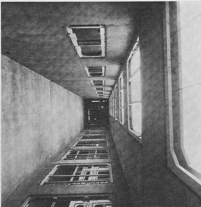
Bild 8. Blick in einen Liftschacht
