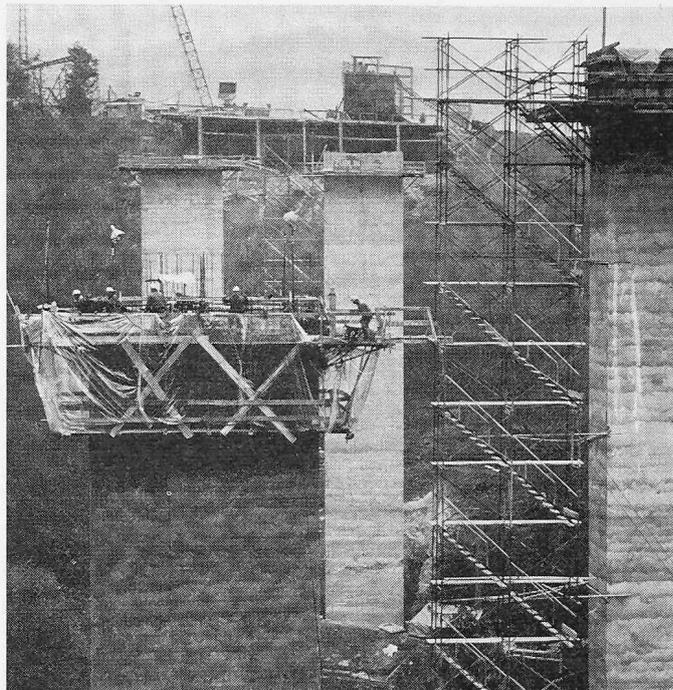
Bild 5. Brückenpfeiler, Kastenquerschnitt  $2,20 \text{ m} \times 7,50 \text{ m}$ , Höhe 50 m. Ziehleistung  $5,50 \text{ m}^3$  je 24 Stunden
