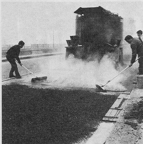
Bild 3 (links). Aufbringen eines dünnen Asphaltmastix-Überzuges mit Lucobit-Zusatz
