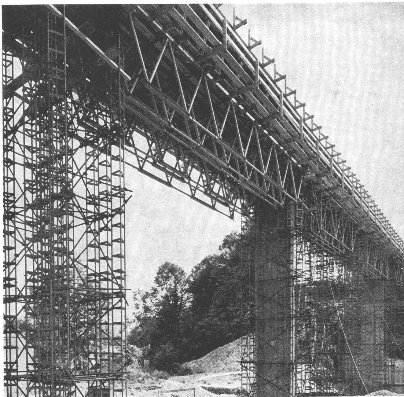
Kaistenbachbrücke bei Laufenburg AG, Länge 154 m, Lehrgerüst ausgeführt für die Arbeitsgemeinschaft Ad. Schäfer + Cie. AG, Aarau/AG Conrad Zschokke, Zürich
