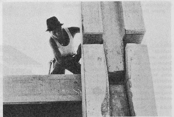
Montage einer Stütze
