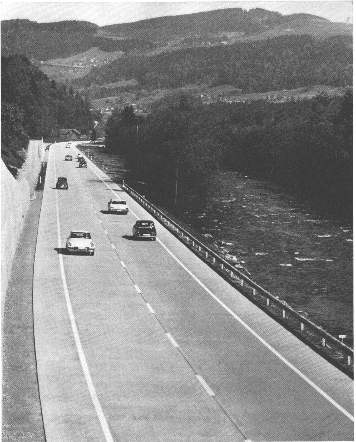
T 10, Bern—Luzern, Umfahrung Malters LU, Betonbelag
