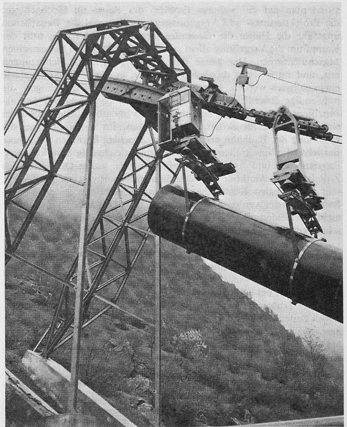
Bild 5. Schwerlastbahn Piano di Peccia. Bauherr: Kraftwerke Maggia SA; Projekt: A. Schönholzer; Ausführung: Habegger, Thun, und Tenconi, Airolo (Photo H. Heiniger, Spiez)
