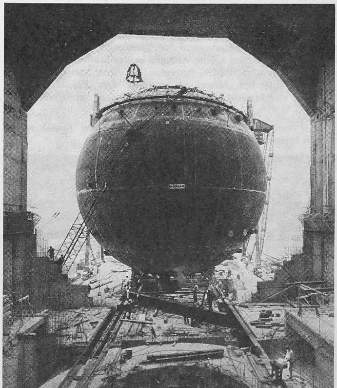
das Druckabbausystem und die Zwangsumlaufkreise aufnehmen. Um die Bauzeit zu verkürzen, wurden der Sicherheitsbehälter und das Reaktorgebäude räumlich getrennt und gleichzeitig gebaut. Dadurch konnten acht Monate Bauzeit eingespart werden. Nach der Fertigstellung beider Teile wurde der Behälter auf Schienen mittels hydraulischer Pressen in das Gebäude hineingezogen (Bild 1). Diese Arbeit nahm rund zehn Tage in Anspruch. DK 621.039.536
