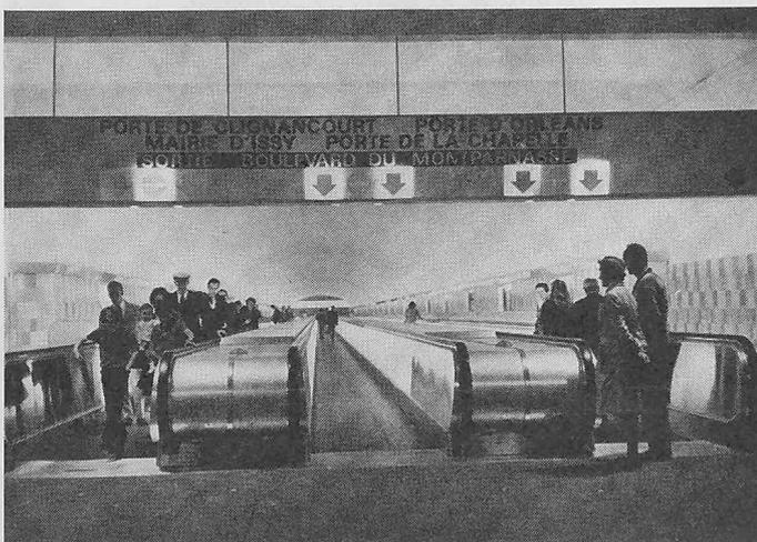
kehrstrom die Personenbänder in der einen oder anderen Richtung gefahren werden, Bild 1. Jedes Band hat eine Breite von 1200 mm und fördert bei einer Geschwindigkeit von 50 m/min bis zu 12 000 Personen/h. Mit solchen Anlagen können Steigungen bis zu 12° überwunden werden. DK 656.52
