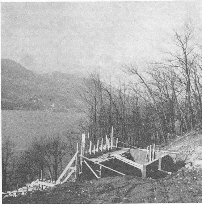
«Schöner Bauplatz» gesucht — und gefunden! Auf aussichtsreicher Hangschulter im Waldbereich oberhalb Carabietta TI wurde für den Bau eines Ferienhauses gerodet
